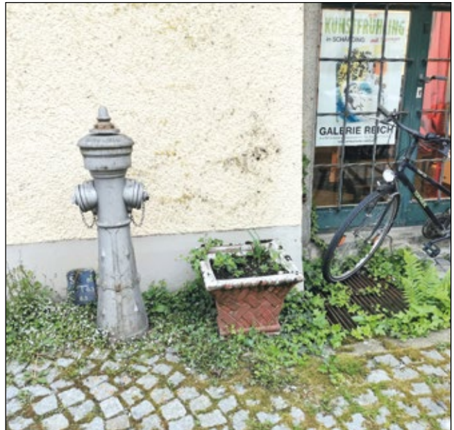
Abb. 4: „Schärdinger Kunstfrühling“ – ausgerufen durch das bezaubernde Pflanzenensemble im Bereich eines Lichtschachtes auf dem Stadtplatz in Schärding – mit Mauer-Zimbelkraut ( Cymbalaria muralis ), Efeu ( Hederix helix ) und dem Echten Wurmfarn ( Dryopteris filix-mas )
